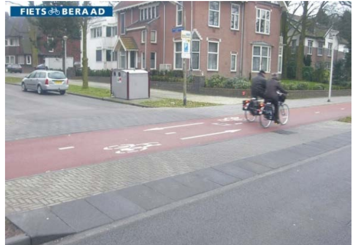
Photo 4 Exemple d'une intersection sans feux de circulation, ni arrêts avec des mesures d'apaisement de la circulation (distance entre la circulation motorisée et la piste cyclable de cinq mètres et traverses surélevées)
