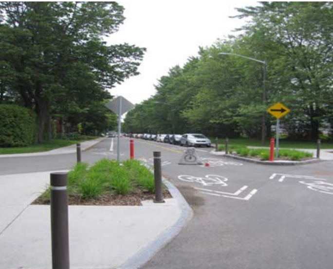
Photo 3 Exemple d'une vélorue avec déviation et saillie de trottoir, rue Père-Marquette, Québec
