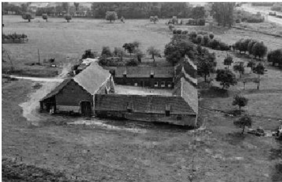
La ferme des Moineaux (Hof ter Musschen) dans son environnement champêtre : vue vers le Sud. À gauche, la grange (qui deviendra espace de réception) et en haut à droite, le boulevard de la Woluwe.
