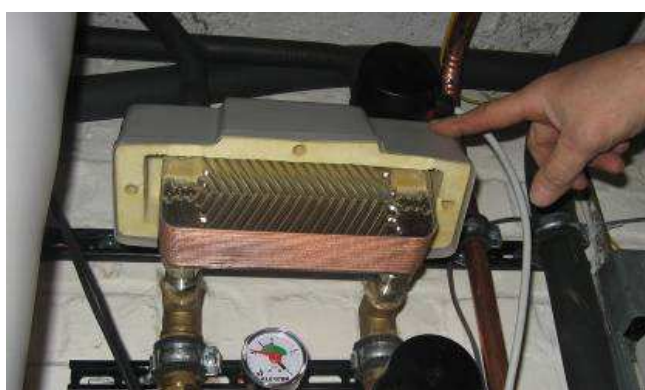
Photos 18 et 19 : Echangeurs à plaque
