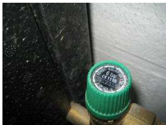
Photos 8 et 9 : Soupape de sécurité et bac récolteur du fluide caloporteur antigel
