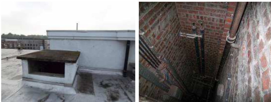
Photos 1 et 2 : Gaine technique reliant la toiture au sous-sol
