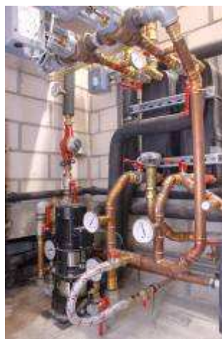
Photos 5 et 6 : Mesure de débit et vue d'une pompe au sein du circuit primaire
