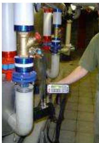
Photos 5 et 6 : Mesure de débit et vue d'une pompe au sein du circuit primaire
